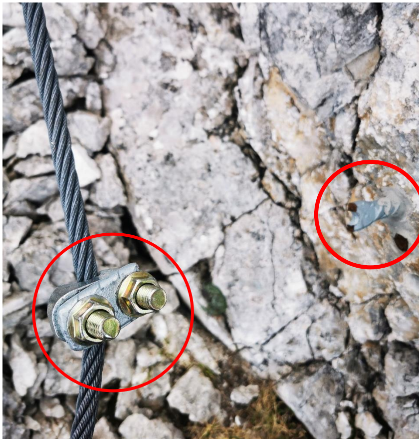
Zu dünne Anker, Schwachstellen an den Schmiedestellen
