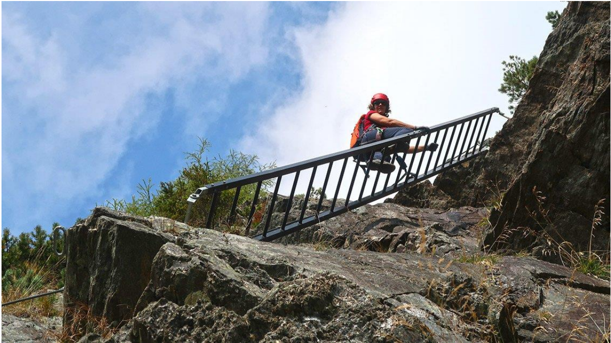
Modulare Leitersysteme, geprüft in Anlehnung an die Klettersteignorm EN16869-2018.
