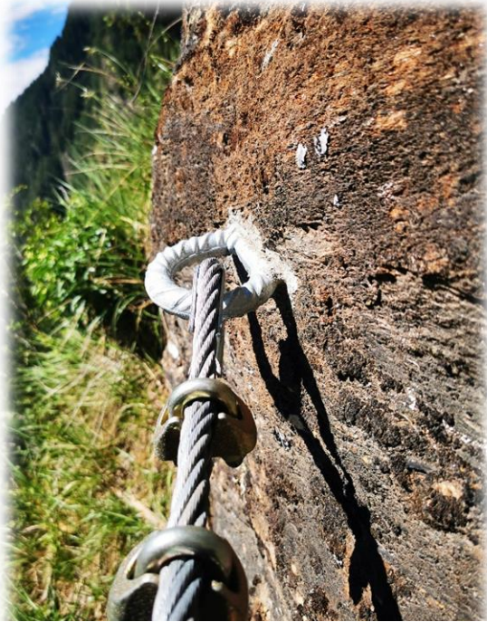
Endanker geprüft nach Klettersteignorm EN16869-2018.
