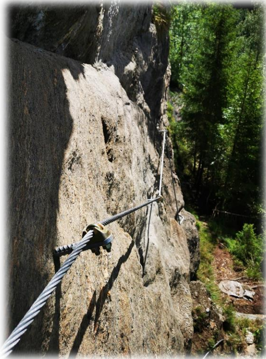
Standard Anker in Anlehnung nach Klettersteignorm EN16869-2018
