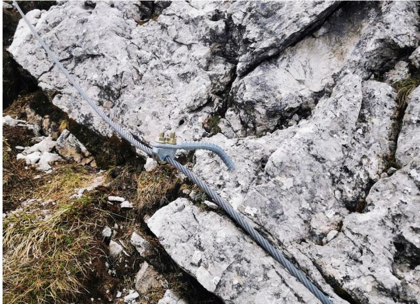
Schneelast nicht beachtet (zu dünne Anker)
