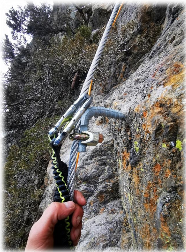
Vertikalanker ohne gefährliche Knickwirkung des Karabiners und Normklemme nach EN13411 in Anlehnung nach Klettersteignorm EN16869-2018
