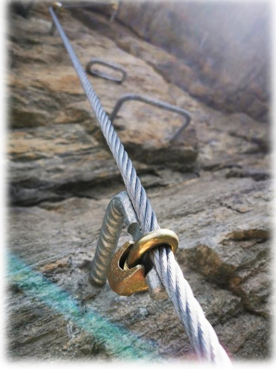
Mit den Vertikalankern werden konische Gummipuffer überflüssig
