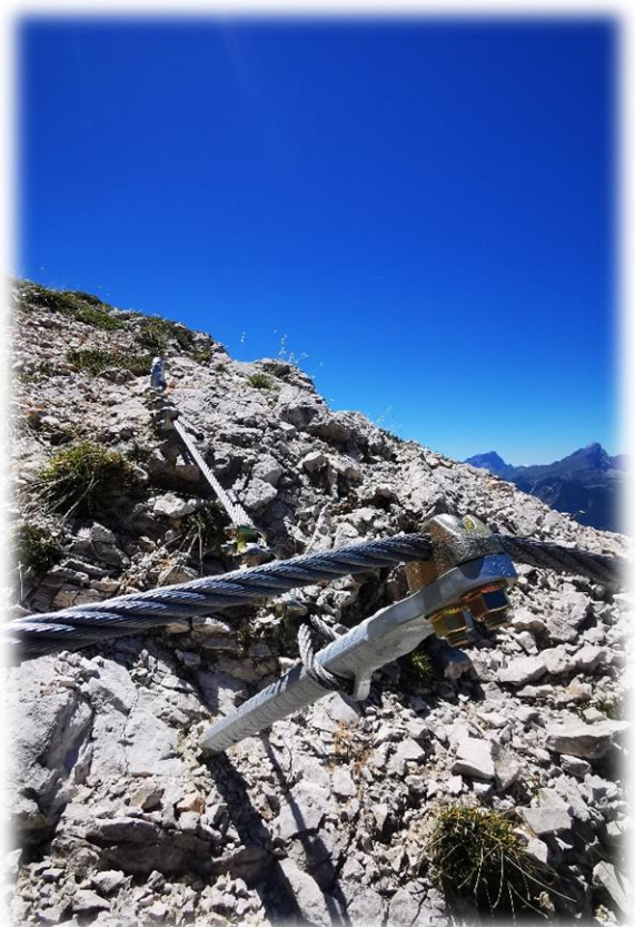
Geländerstangen mit Abspannösen für hohe Stabilität geprüft nach Klettersteignorm EN16869-2018
