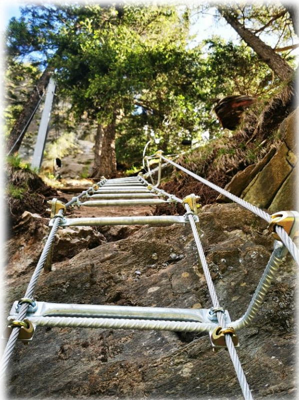
Hängeleiterstufen geprüft nach Klettersteignorm EN16869-2018
