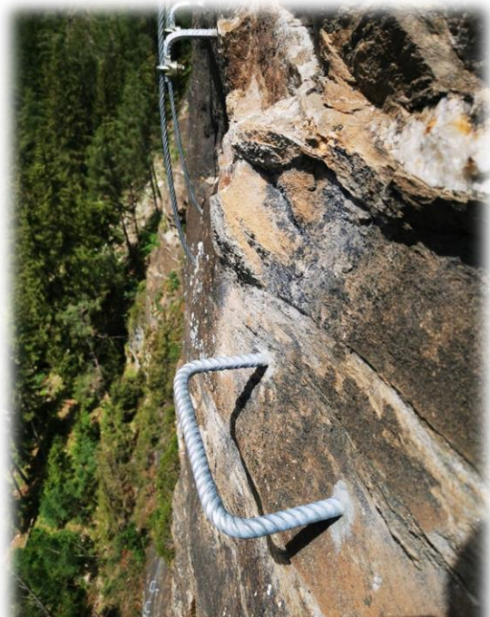
Trittbügel geprüft nach Klettersteignorm EN16869-2018.
